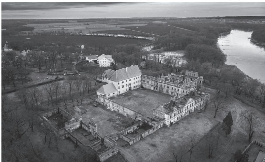
Ryc. 1. Zamek w Siedlisku, widok od północnego zachodu. Fot. Grzegorz Topa/Poland By Drone, 2022
