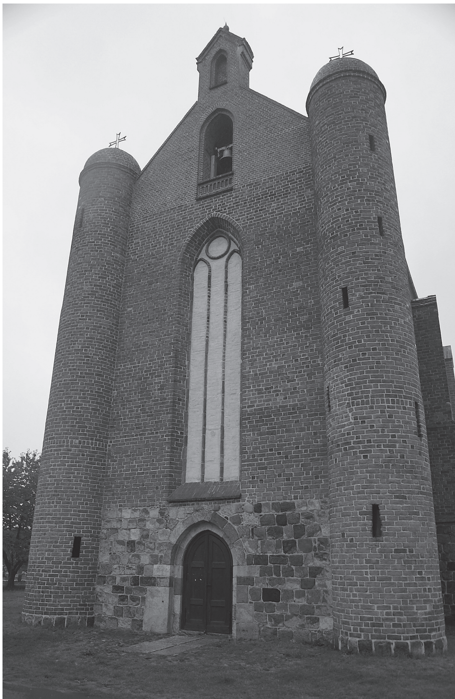
Ryc. 3. Chwarszczany, widok elewacji zachodniej kościoła od strony południowo-zachodniej. Fot. K. Wroński
