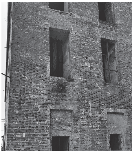
Ryc. 14. Zamek w Słońsku, ornamentyka elewacji północnej. Strzałkami oznaczone mniejsze blendy tarczowe. Fot. K. Wroński
